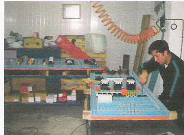
Armado panel eléctrico
